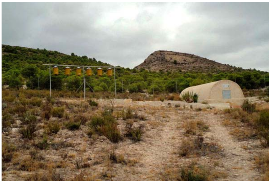
Estación polinizadora junto al aljibe construido en HYLA.
